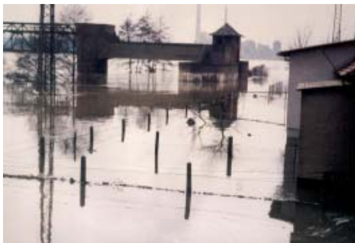
Hochwasser 1970 ( an der Schwanengasse, Blick auf Schleusenbunker)
